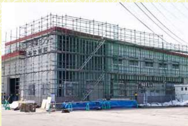
繁忙期に向けた野菜の集出荷施設改修工事(令和4年3月現在)
